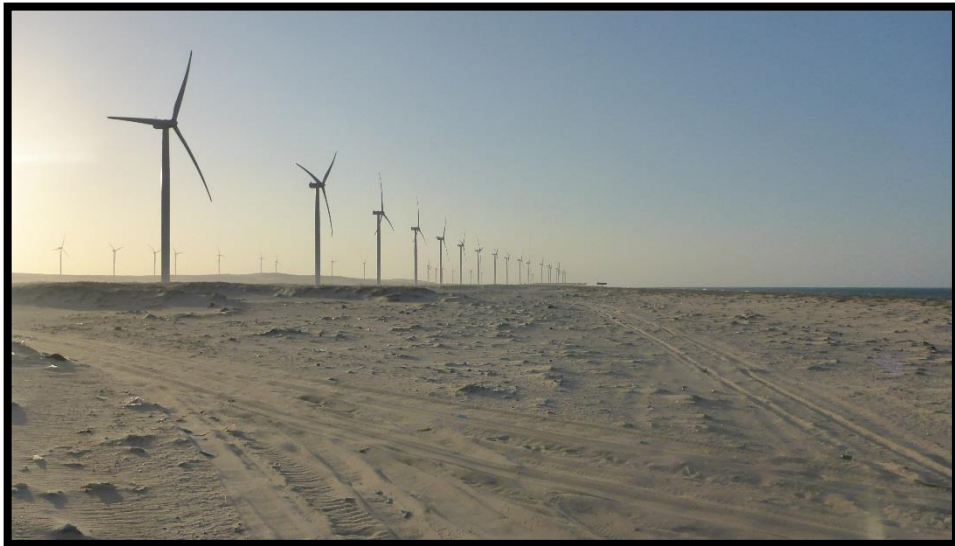
Figura 11 – Alteração tecnogênica por meio da implantação de aerogeradores sobre dunas móveis no Município de Aracati, Ceará. (Foto: Geoambiente, 2015)
