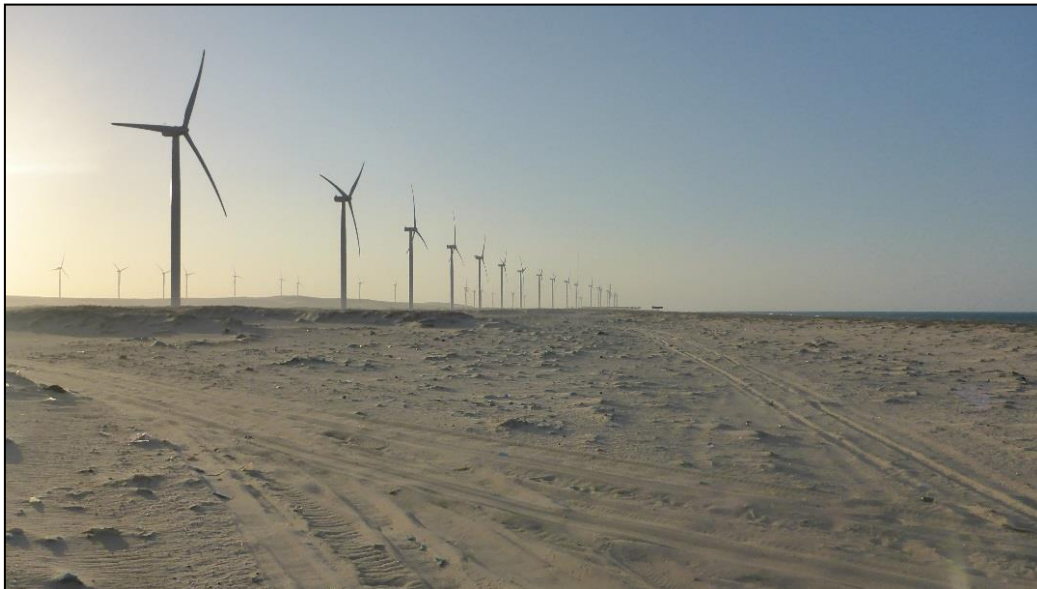
Figura 21: Alteração tecnogênica por meio da implantação de aerogeradores sobre dunas móveis no Município de Aracati (CE). Coordenadas UTM (Fuso 24 Sul, Datum SIRGAS2000): 639862,87m E; 9505141,35m N. Data:22/07/2015
