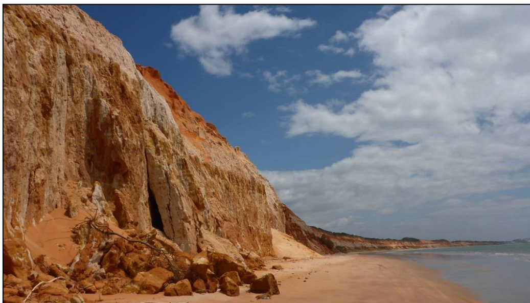
Figura 26: Área degradada com solo exposto em falésia, pertencente ao Município de Aracati (CE). Coordenadas UTM (Fuso 24 Sul, Datum SIRGAS2000): 661019,00m E; 9486536,79m N. Data:22/07/2015.
