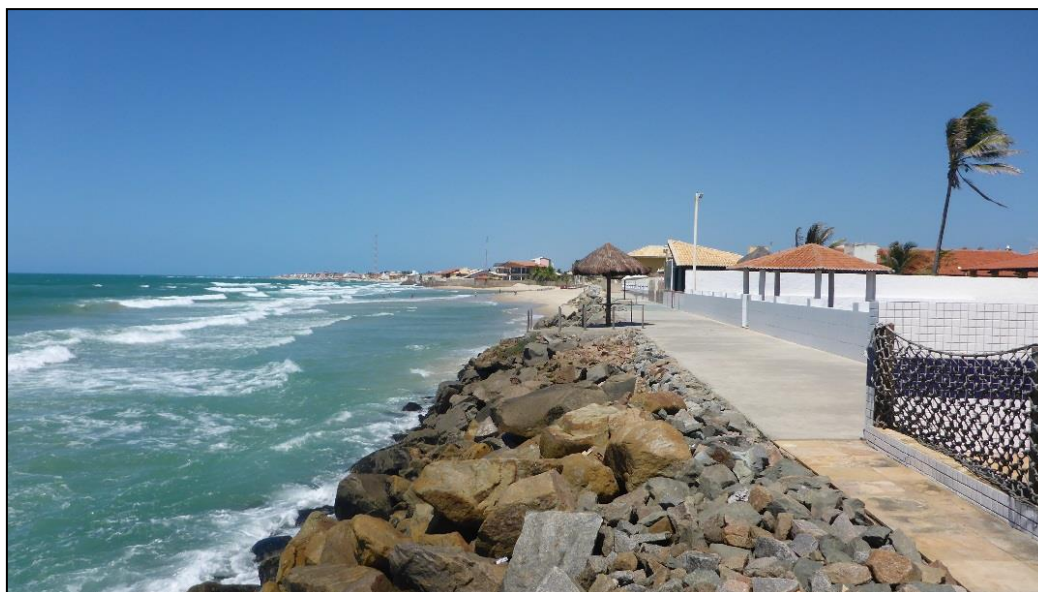
Figura 24: Área edificada próxima ao oceano no Município de Cascavel (CE). Coordenadas UTM (Fuso 24 Sul, Datum SIRGAS2000): 588198,12m E; 9554338,84m N. Data:25/07/2015.
