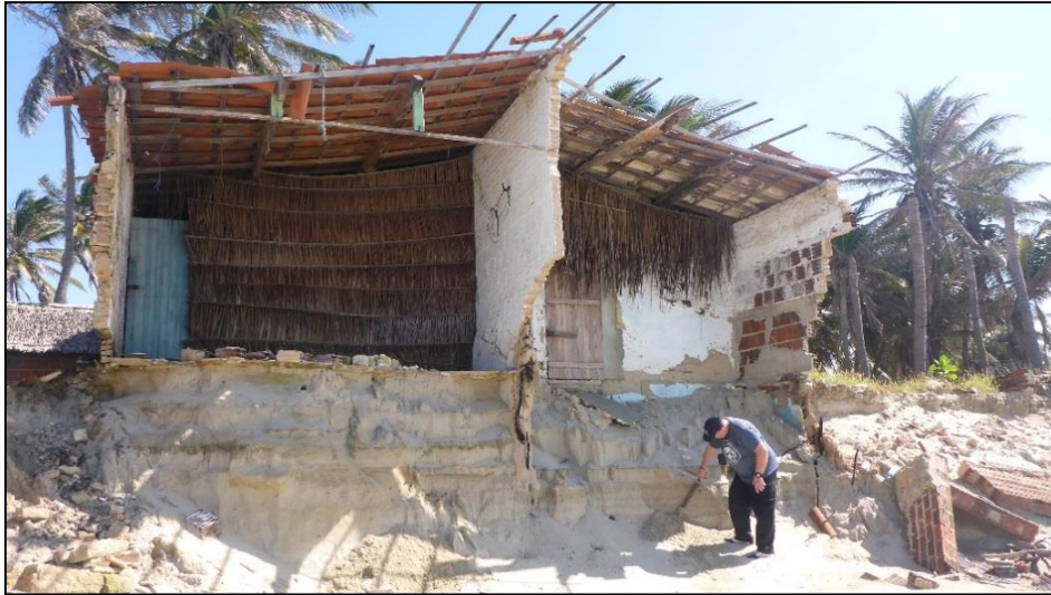
Figura 76: Falésia em contexto de Terraço Marinho no município de Beberibe (CE). Coordenadas UTM (Fuso 24 Sul, Datum SIRGAS2000): 618654,96 m E; 9522649,30m N. Data: 15/04/2015.
